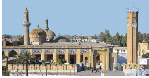
Abdülkadir Geylani Türbesi (Bağdat)
